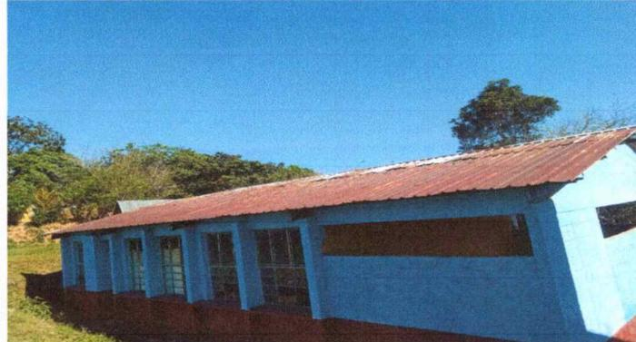
Foto1: Se observa un deterioro de la estructura metalica de las laminas oxidadas y piezas de vidrios quebrados modulo 1
